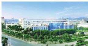
Завод в г.Жангжоу
