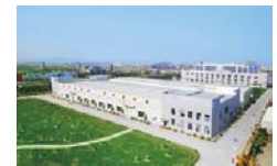
Завод в г. Джяомэй
